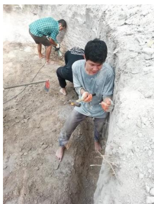
1.6 ขุดดินเป็นร่อง (สี่เหลี่ยมผืนผ้าแนวตั้ง) โดยรอบวงกลม เพื่อทำเป็นคานคอดินรับน้ำหนักของแท็งก์ (ขั้นตอนเดียวกับการทำคานคอดินในกระบวนการก่อสร้างทั่วไป) กำหนดจุดที่จะเป็นท่อระบายน้ำ ขุดวางท่อขนาด 4 นิ้วให้ลอดใต้คานคอดิน โดยให้ปลายที่อยู่ใกล้แท็งก์มีช่อง 90 องศา ต่อก่อโพล์ขึ้นมาประมาณ 30 ซม. (เพื่อตัดปลาย)
