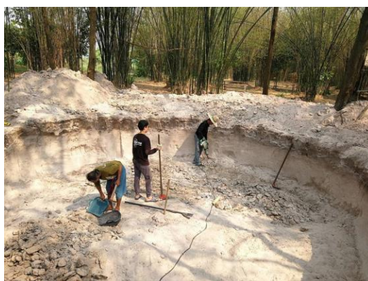
1.6 ขุดดินเป็นร่อง (สี่เหลี่ยมผืนผ้าแนวตั้ง) โดยรอบวงกลม เพื่อทำเป็นคานคอดินรับน้ำหนักของแท็งก์ (ขั้นตอนเดียวกับการทำคานคอดินในกระบวนการก่อสร้างทั่วไป) กำหนดจุดที่จะเป็นท่อระบายน้ำ ขุดวางท่อขนาด 4 นิ้วให้ลอดใต้คานคอดิน โดยให้ปลายที่อยู่ใกล้แท็งก์มีช่อง 90 องศา ต่อก่อโพล์ขึ้นมาประมาณ 30 ซม. (เพื่อตัดปลาย)
